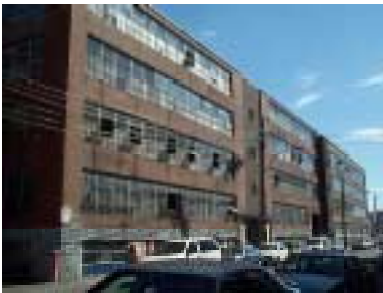
Locaux de l'Atelier Circulaire 40, rue Molière
